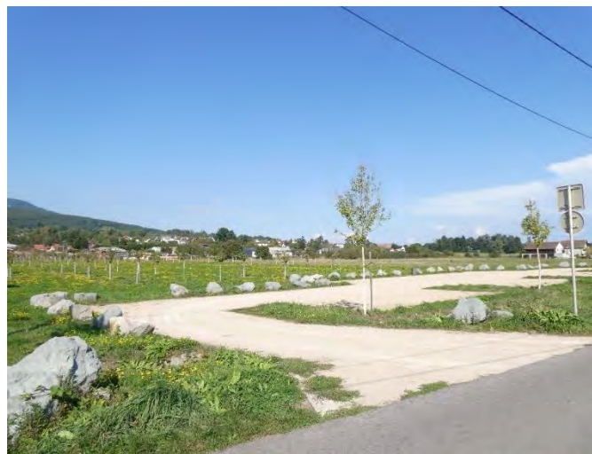
Entrée du site aménagé en zone de stationnement
